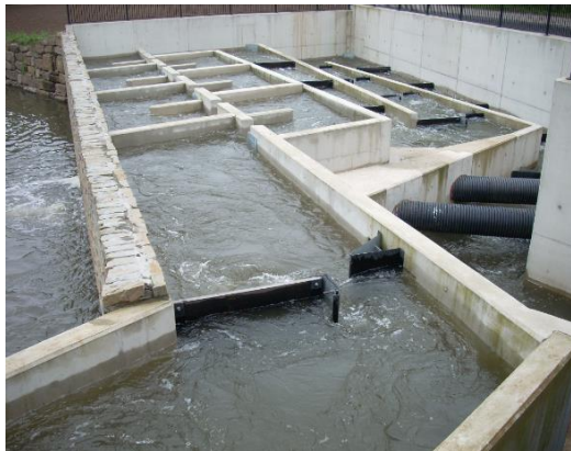
Passe à poissons de la centrale hydroélectrique de Roermond (Pays-Bas) (Photo : Johan Coeck)
