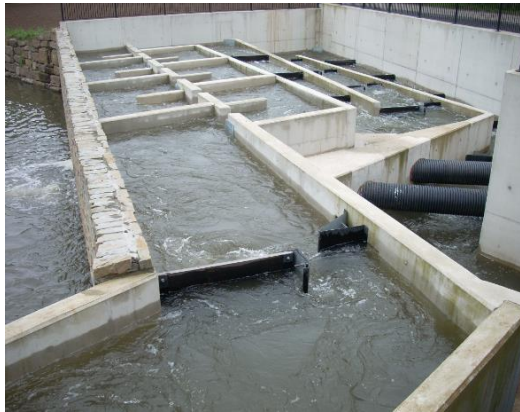
Der Fischpass am Wasserkraftwerks in Roermond (Niederlande) (Foto: Johan Coeck)
